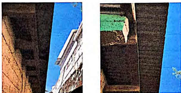
Foto 8: No hay canales de agua de lluvia
