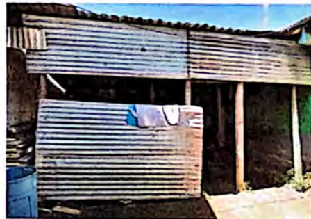
Foto 6: Reparación de muro perimetral
