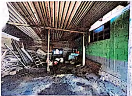
Foto 5 : Reparación de muro perimetral
