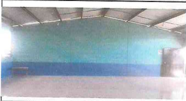
Foto1: se instaló piso ceramicos aulas de primaria
