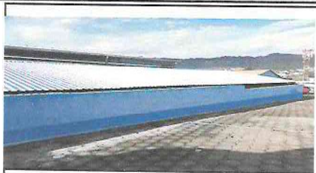
Foto 2: así quedo el repello exterior
