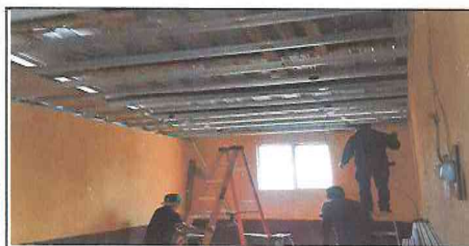
Foto 5: instalando sistema electrico
