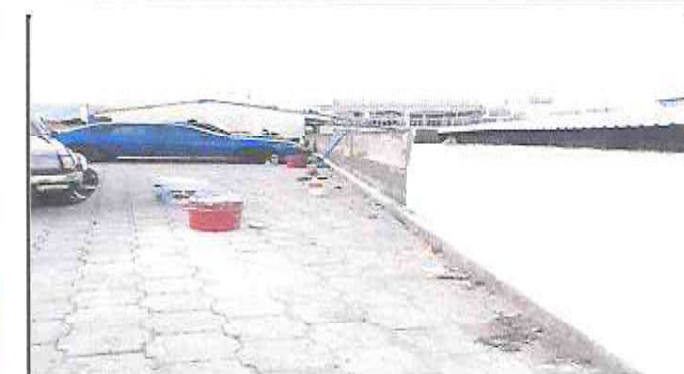
Foto 4: colocacion de sabieta en exterior
