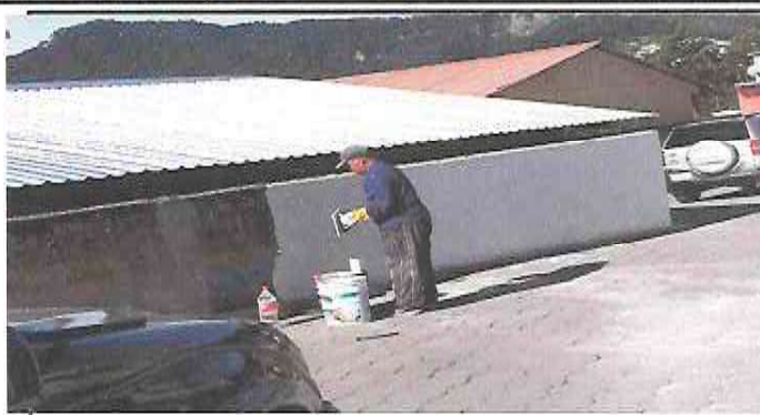
Foto 2: colocación de repello
