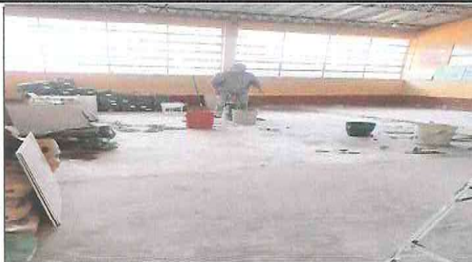
Foto1: instalando piso cerámico en aulas de Primaria
