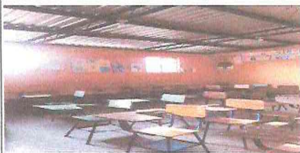
Foto1: cambio de piso por cerámico en las aulas de primaria
