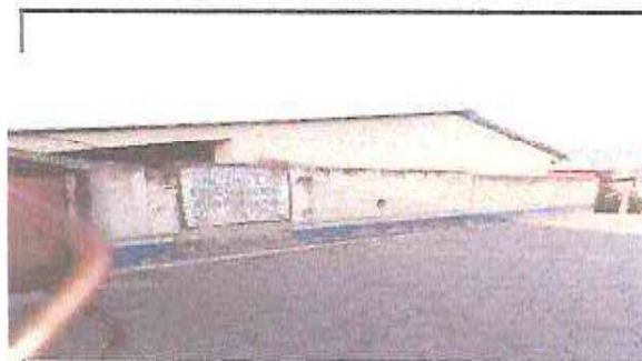
Foto 4 colocacion de sabieta en la pared
