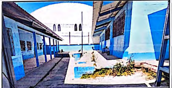
Foto 14: Instalación de canales
