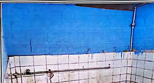
Foto 7: Tubería y llaves de paso en mal estado
