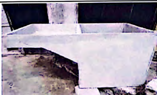
Foto 5: La pila en mal estado
