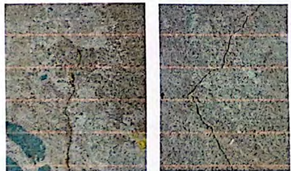
Foto 6: Rajadura de piso rústico en uno de los módulos mas antiguos del establecimiento.
