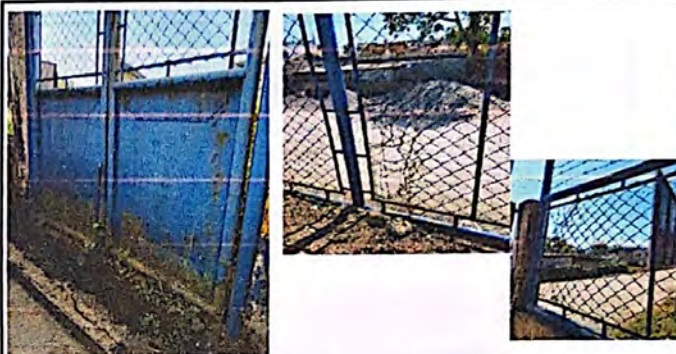
Foto 8: Ingreso de escorrentía de agua pluvial en predio escolar por falta de muro de concreto -portón alterno inhabilitado-. Deterioro de mallas en 5 secciones del perímetro.
