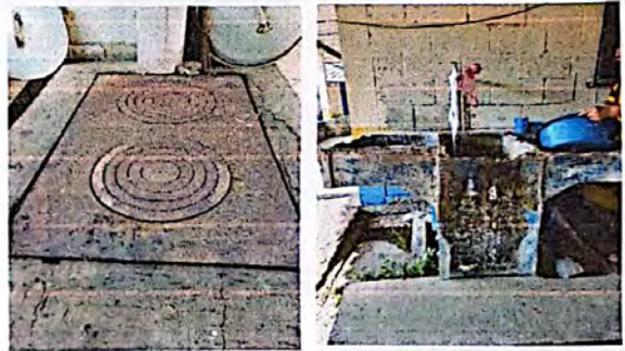
Foto 4: Deterioro de plancha de estufa de leña y de lavadero.
