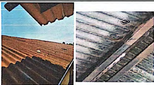
Foto 9: Deterioro de techo de lámina de dos aulas y corredor.
