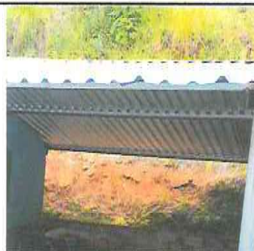
Foto 2: Sustitucion de estructura de techo y lamina por lamina troquelada calibre 26.
