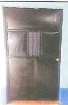
Foto 5: Sustitucion de dos puertas por metal
