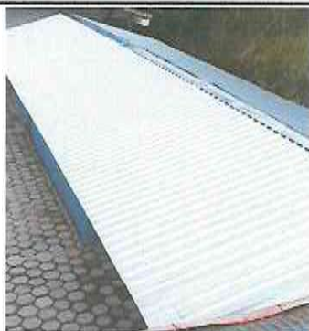
Foto1: Sustitucion de lamina por lamina troquelada calibre 26
