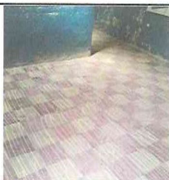
Foto 3: Sustitución de piso cerámico en la Dirección
