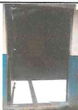
Foto 5: Sustitución de dos puertas por metal
