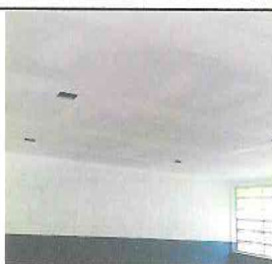
Foto 4: Sustitución de tablayeso para cielo falso en tres aulas
