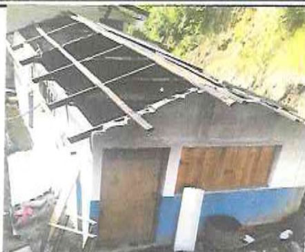
Foto 1: Sustitución de lámina por lámina troquelada calibre 26
