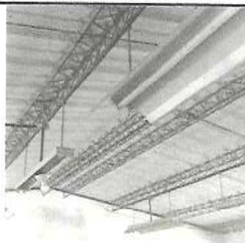
Foto 4: Sustrucción de tablayeso para cielo falso en tres aulas
