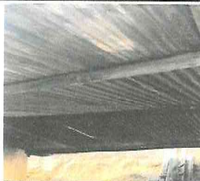
Foto 2: Sustrucción de estructura de techo y lamina por lamina troquelada calibre 26.
