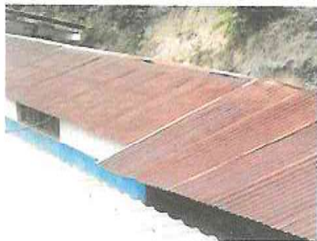
Foto 1: Sustrucción de lamina por lamina troquelada calibre 26
