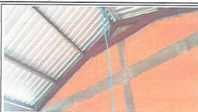
Foto 2: Sustrucción de estructura de madera por metal
