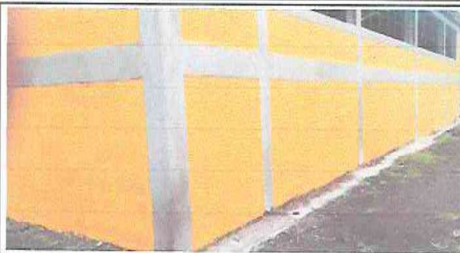
Foto 1: Reparación de muro perimetral
