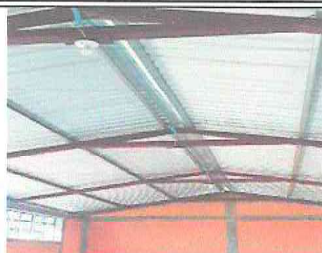
Foto 2: Reparación de sistema eléctrico
