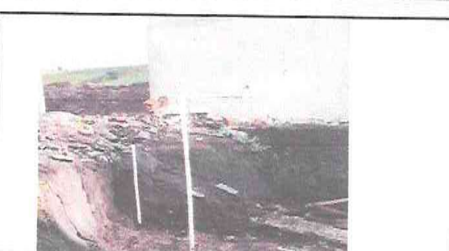
Foto 6: Sustrucción de tubería línea principal y llave de chorro
