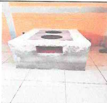
Foto 3: Mantenimiento de estufa rural (completo) incluye chimenea y plancha de metal
