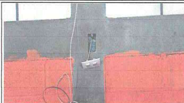
Foto 2: Reparación de sistema eléctrico
