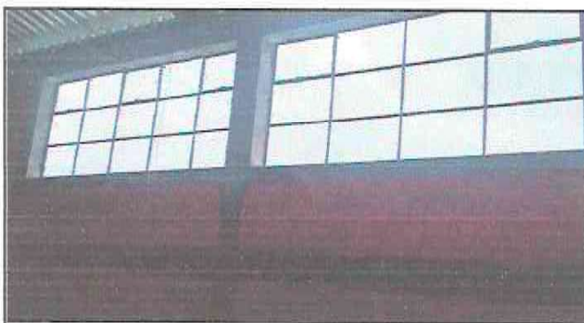
Foto 3: Sustitucion de ventana de madera a metal y vidrio
