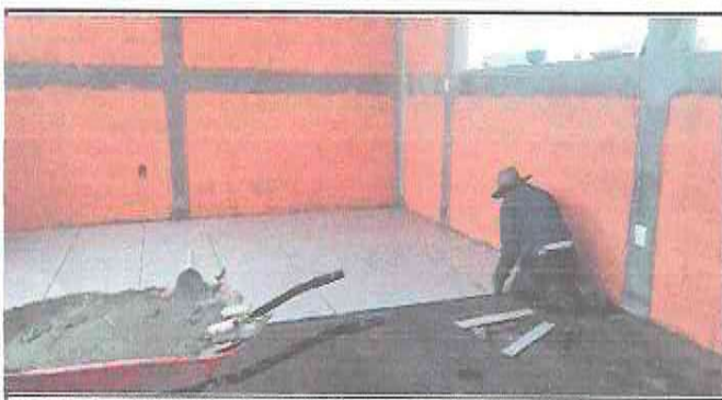
Foto 5: Sustitucion de piso de torta de cemento por cerámico
