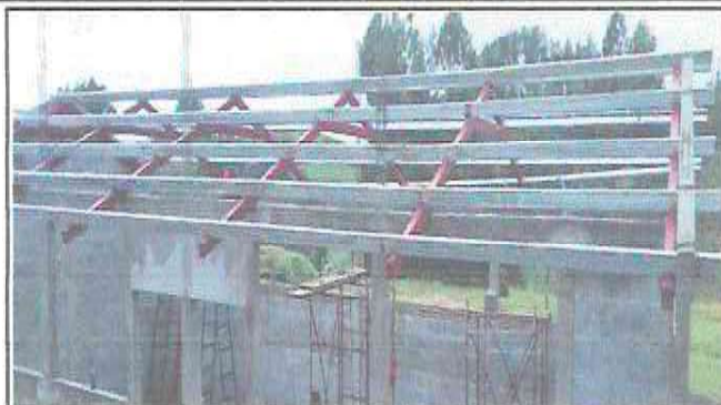
Foto 2: Sustitución de estructura de madera por metal
