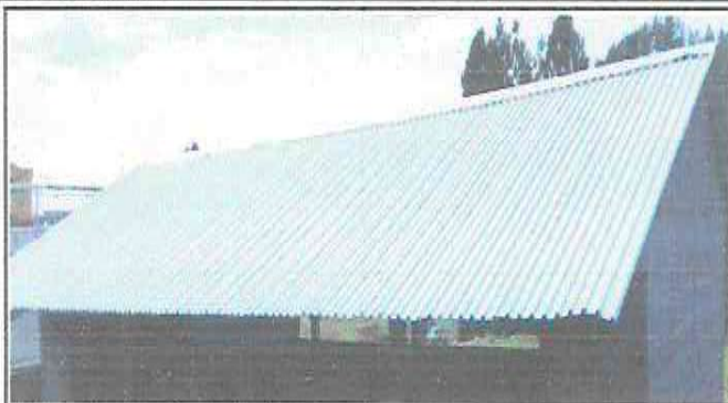
Foto1: Sustitución de lámina
