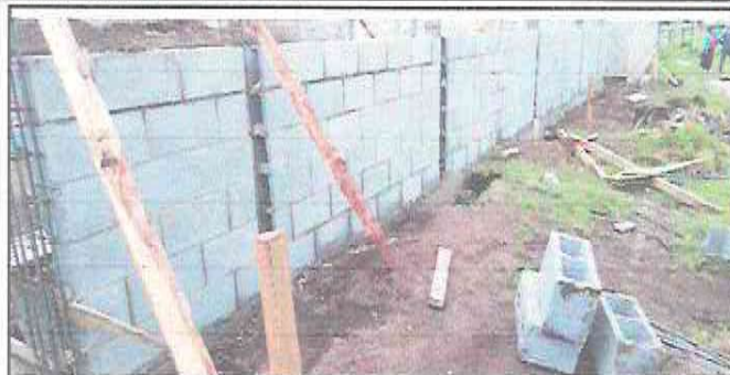
Foto 1: Reparación de muro perimetral
