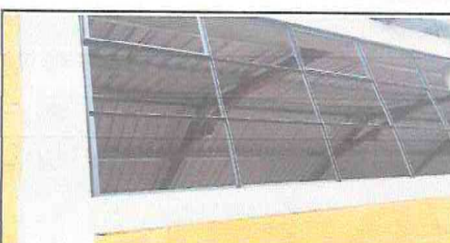
Foto 6: Sustitución de balcones
