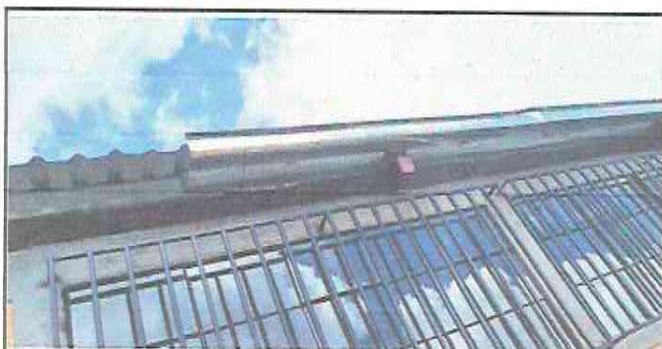
Foto 5: Instalación de canales y bajadas de aguas pluviales
