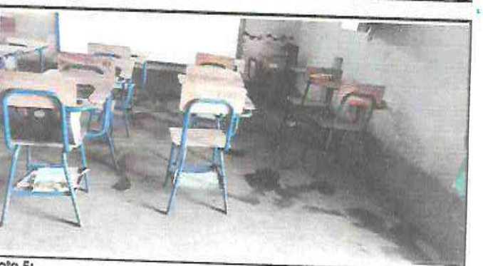
Foto 5: Sustitución de piso de torta de cemento
