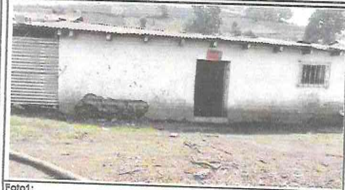
Foto 1: Sustitución de lámina
