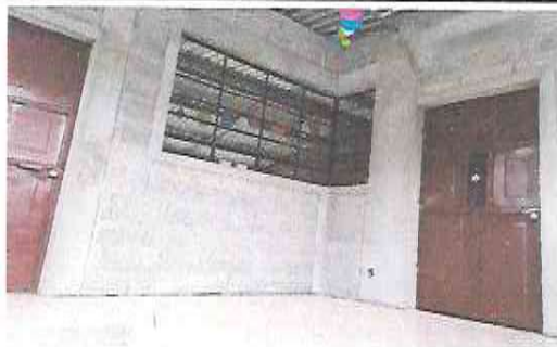
Foto 5: Sustrucción de puerta
