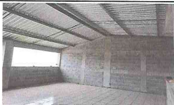
Foto 6: Sustrucción de piso.
