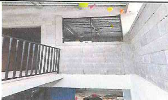
Foto 3: Reparación de módulo perimetral e impermeabilización de losa.
