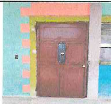
Foto 2: Sustrucción de puerta de preprimaria.
