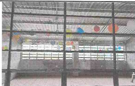
Foto 4: Sustrucción de ventanas.
