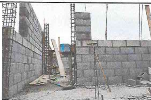
Foto 3: Reparación de módulo perimetral e impermeabilización de losa.
