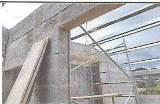
Foto 4: Sustrucción de ventanas.
