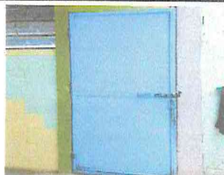
Foto 2: Sustrucción de puerta de Preprimaria
