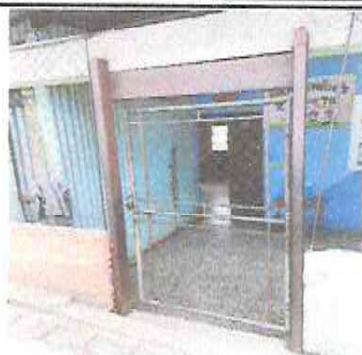
Foto 1: Sustrucción de puerta Principal acceso a módulo de Preprimaria
