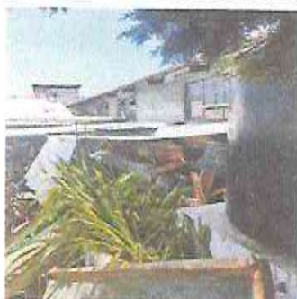
Foto 3: Reparación de Muro Perimetral e Impermabilización de Losa
