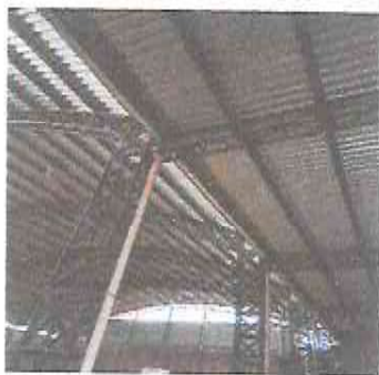
Foto7: Reparación de bajada de agua pluvial
