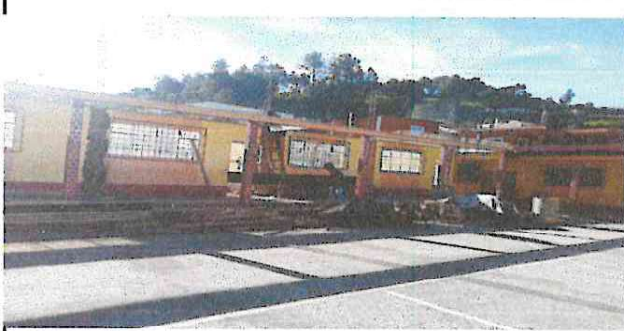
Foto 3: Columnas fundidas
