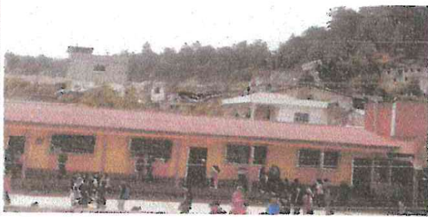
Foto1: La fotografía muestra el techo del aula que se va cambiar
