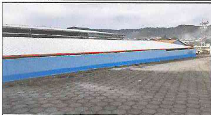
Foto1: AULAS CON NUEVO TECHADO DE LAMINA TROQUELADA
