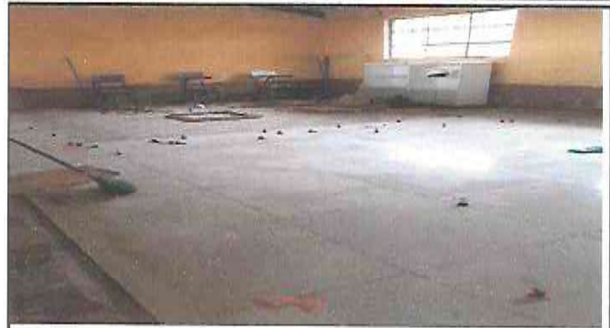
Foto 2: COLOCANDO PISO CERAMICO
