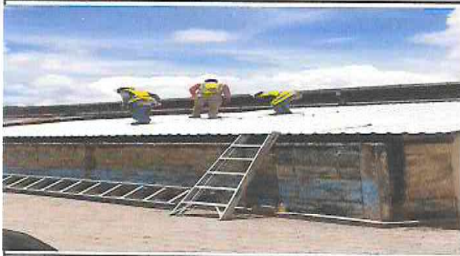
Foto1: CAMBIANDO TECHO DE LAMINA POR LAMINA TROQUELADA
