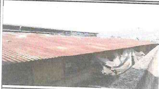
Foto1: cambio DE TECHO DE LAMINA
