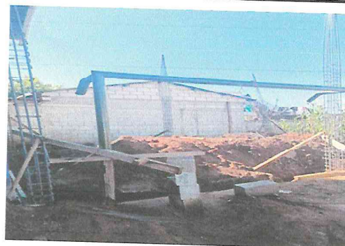
Foto 2: Reparación de muro perimetral
