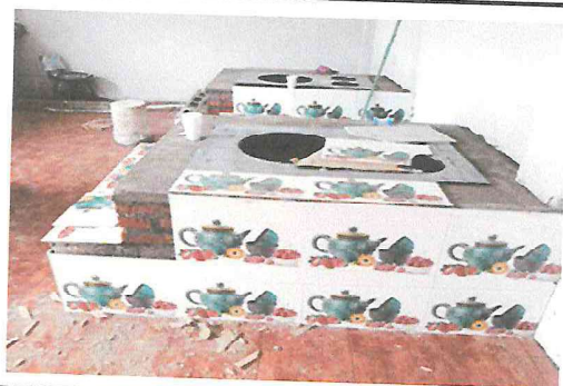
Foto 5: Sustitución de estufa rural completa, con chimenea y plancha de metal
