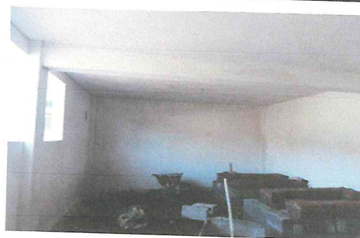
Foto 6: Repello y cernido de paredes de cocina escolar.
