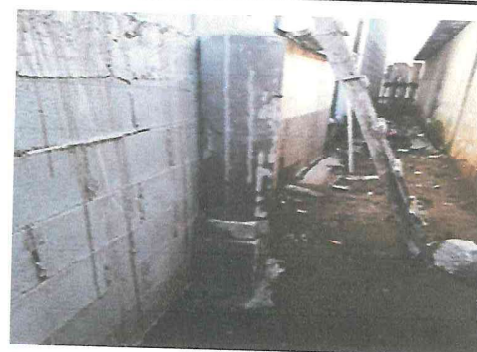
Foto 4: Reforzamiento de muro perimetral con columnas y vigas de concreto
