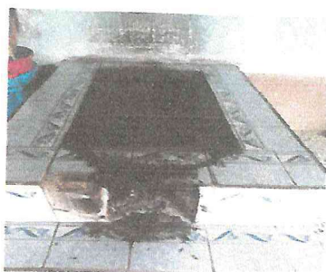
Foto 5: Se necesita sustituir estufa rural completa, con chimenea y plancha de metal.
