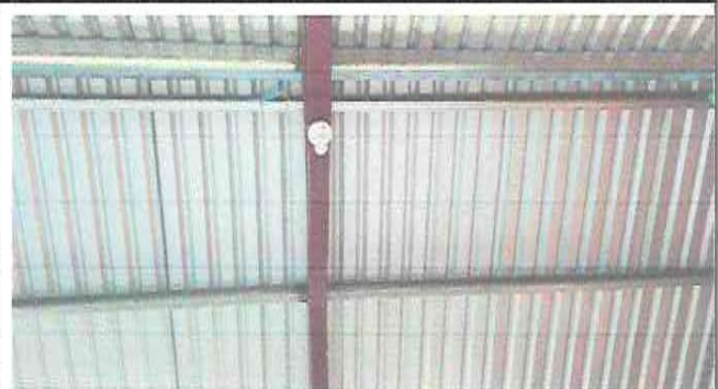
Foto 2: Reparación de sistema eléctrico
