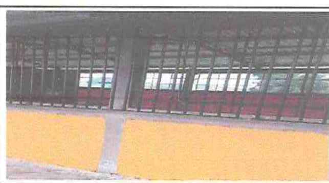
Foto 6: Sustitución de balcones
