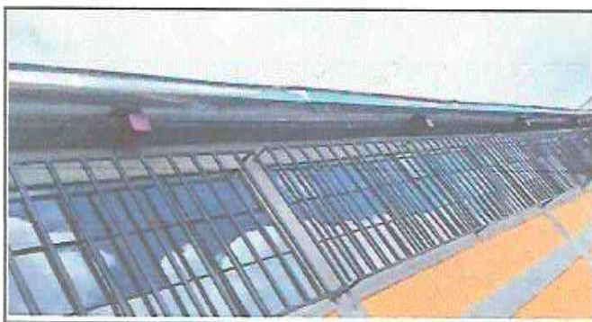
Foto 5: Instalación de canales y bajadas de aguas pluviales
