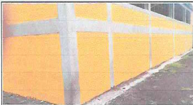
Foto 1: Reparación de muro perimetral
