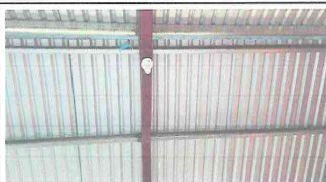
Foto 2: Reparación de sistema eléctrico
