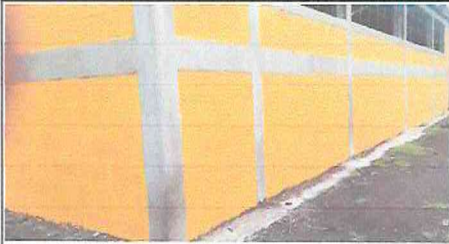
Foto 1: Reparación de muro perimetral
