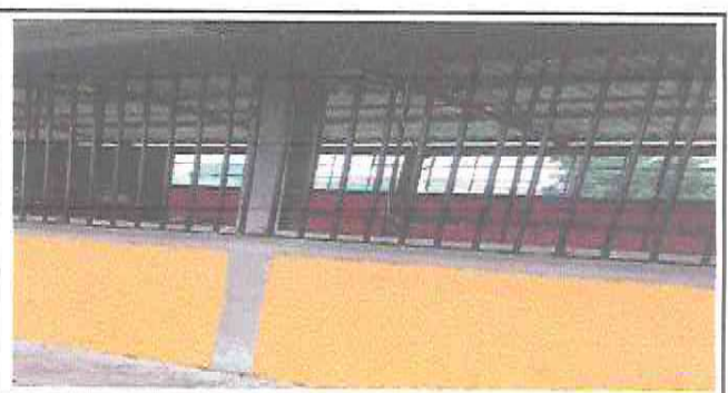
Foto 6: Sustitución de balcones
