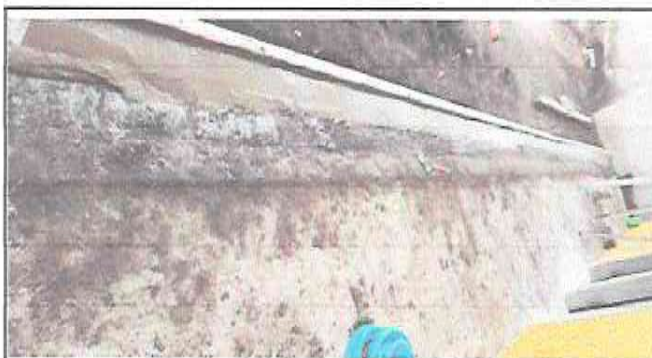
Foto 4: Cunetas de concreto y pinturas en muros exteriores e interiores
