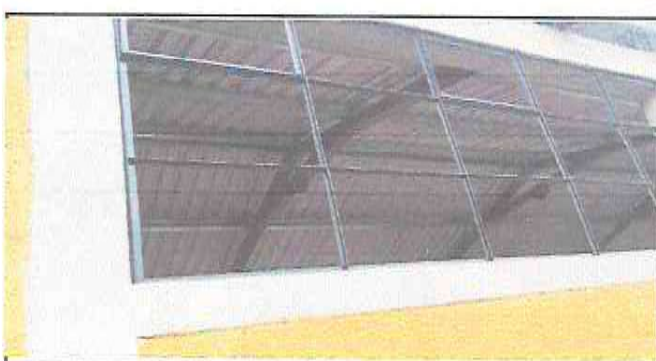
Foto 6: Sustitución de balcones
