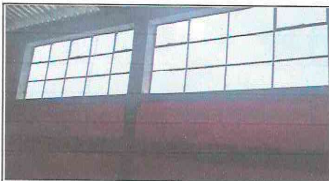
Foto 3: Sustrucción de ventana de madera a metal y vidrio
