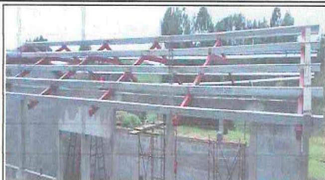
Foto 2: Sustrucción de estructura de madera por metal
