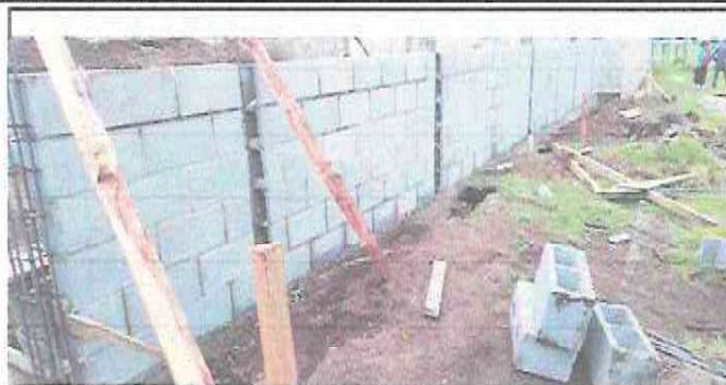
Foto 1: Reparación de muro perimetral
