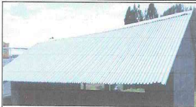
Foto 1: Sustrucción de lámina
