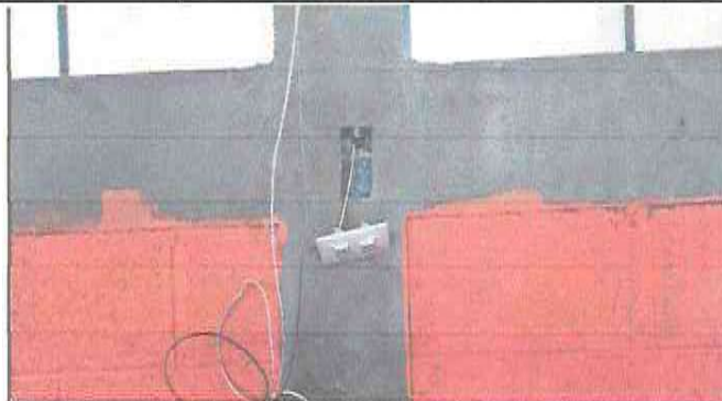
Foto 2: Reparación de sistema eléctrico
