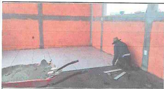
Foto 5: Sustrucción de piso de torta de cemento por cerámico
