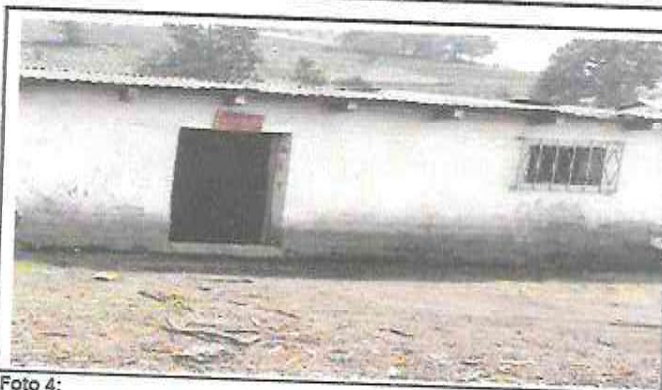
Foto 4: Cunetas de concreto y pinturas en muros exteriores e interiores.
