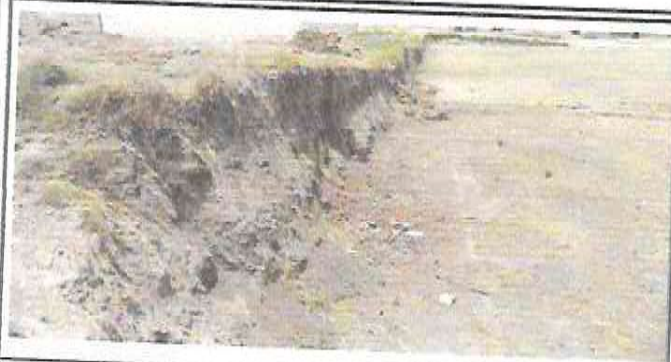
Foto 1: Reparación de muro de contención
