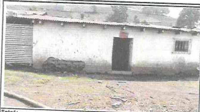
Foto1: Sustitución de lámina
