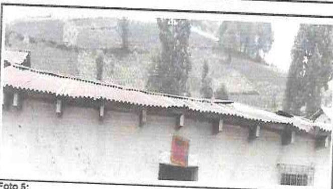
Foto 5: Instalación de canales y bajadas de aguas pluvial
