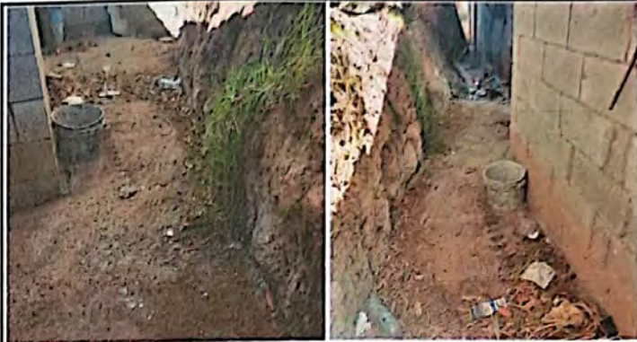
Foto 2: Torta de Cemento en los lados exteriores de las aulas.
