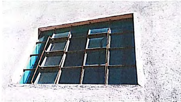
Foto 10: Instalación de balcones en las ventanas de las aulas.
