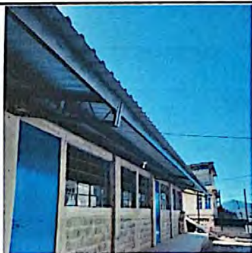
Foto 11: Colocación de canales de PVC
