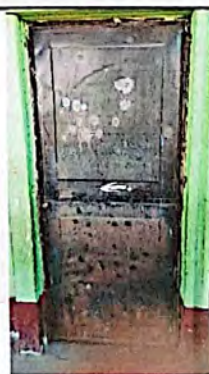
Foto 6: Sustitución de puerta de metal.
