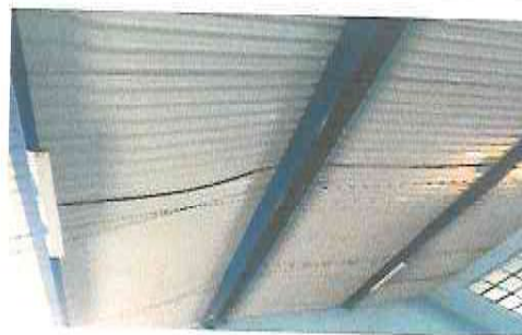
Foto 2: Sustitución y mantenimiento de soporte de metal
