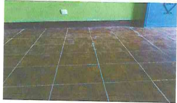
Foto 2: Sustitución de piso de concreto por piso cerámica, color maderas.
