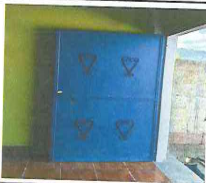
Foto 3: Sustitución de puerta de madera por metal.
