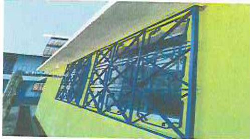
Foto1: Sustitución de ventanas de madera por ventanas de metal con vidrios y balcones.
