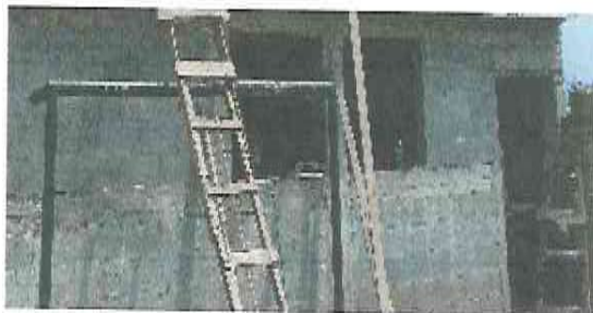
Foto 1: Sustrucción de ventanas en mal estado.
