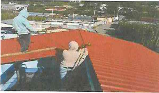
Foto1: Sustitución de laminas en mal estado por láminas troqueladas calibre 26.
