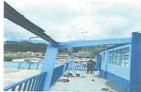
Foto 2: Sustitución de soporte.
