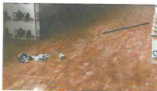
Foto 2: Sustrucción de piso de concreto por piso cerámico color madera.
