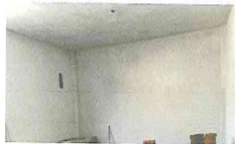
Foto 6: Sustitución de cableado eléctrico y sus accesorios.
