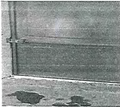
Suministro e instalación de puertas con chapa yale
