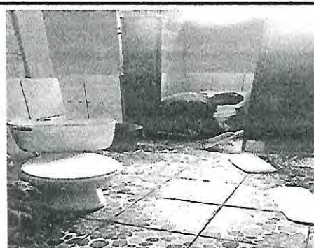
Foto 4: Cambio de inodoros en los baños de los estudiantes de la Escuela con el objetivo que tengan un buen ambiente higiénico.
