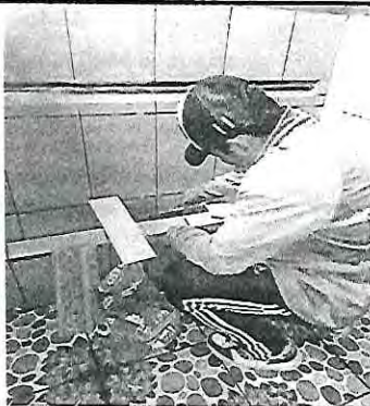
Foto 3: colocación de azulejos en la pared del mingitorio de los servicios sanitarios.
