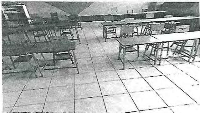
Foto 1: Culminación de la colocación del piso cerámico por los albañiles, en donde se muestra como quedó al final la obra.
