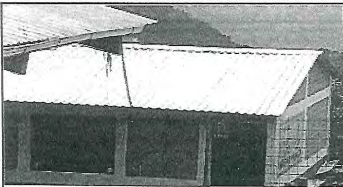
Foto 1: techo de lamina acanalada
