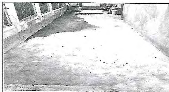
Foto 5: pavimentacion de patio de recreaciones
