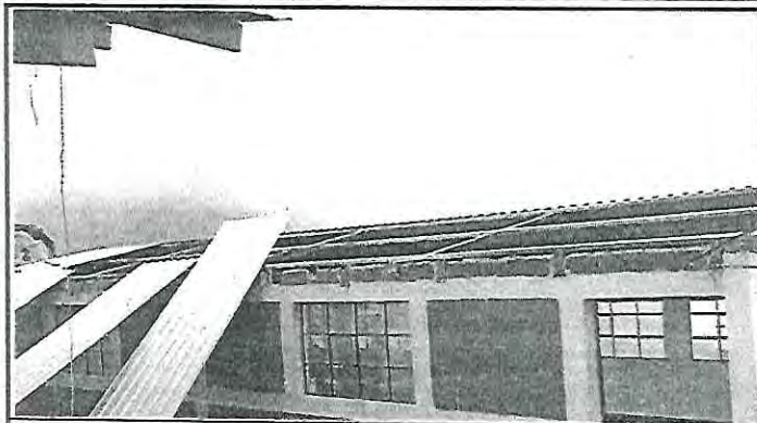
Foto 1: montaje de techo de lamina
