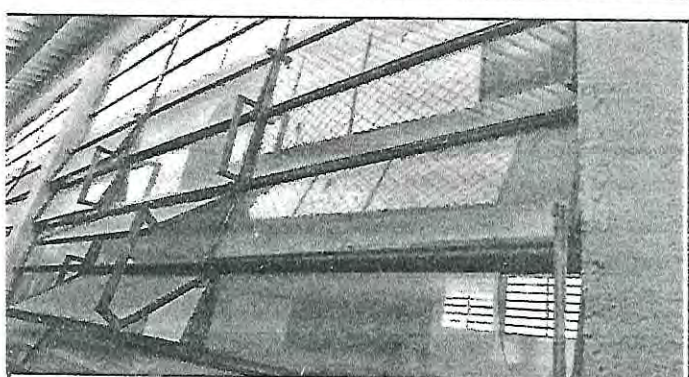
Foto 4: colocacion de valcones en ventanas expuestas
