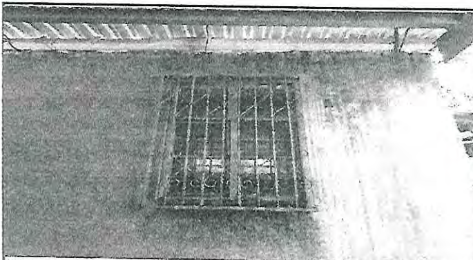
Foto 3: cambio de balcones para ventanas en mal estado
