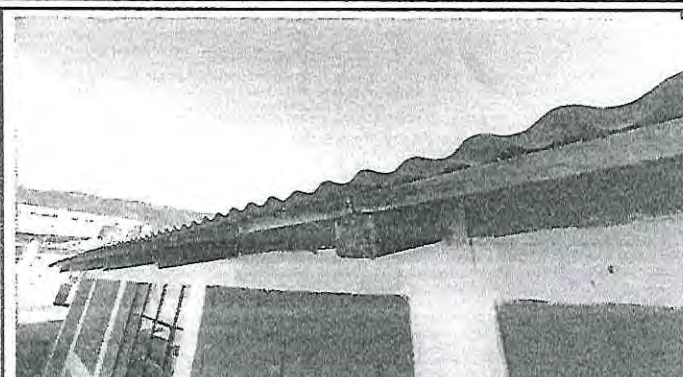
Foto 2: cambio de costaneras para fijacion de laminas
