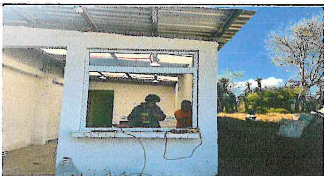
Foto 3: Sustitucion de puertas y ventanas
