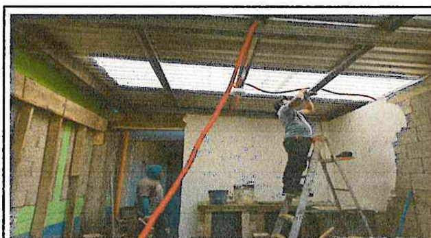
Foto 4: Sistema Eléctrico y sustitucion en el área de la cocina.
