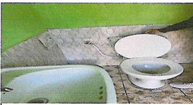
Foto 6: Sustitucion de accesorios de baño por deterioro.
