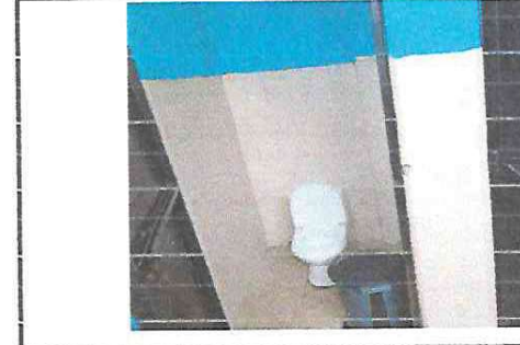
Foto 4. Taza instalada adecuadamente
