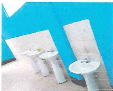
Foto 9. Finalización de colocación de pedestal de lava mano, en sanitario de niñas
