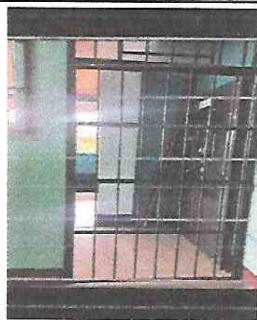
Foto 7. Instalación de puerta de rejas, en dirección
