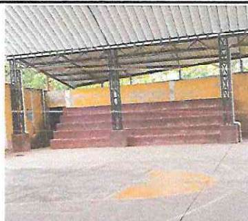
Fotos 8. Colocación de electromalla, en cancha polideportiva.
