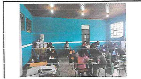
Foto 4. Finalizado de colocación de cielo falso, en dirección y aulas
