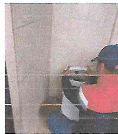
Foto 4: Se cambia un sanitario que se encuentra en mal estado, se cambiara los pedestal de lavamanos y se colocarán a una altura adecuada para los niños.
