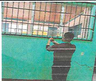
Fotos 2: las ventanas actualmente, se están colocando.
