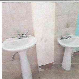
Fotos 9: cambio de pedestales para adaptarlo a la altura de los niños y hacer un uso más eficiente del agua.
