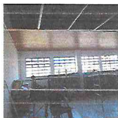
Foto 5: Se colocará cielo falso en 4 salones para disminuir el calor del verano y el ruido que producen las lluvias en invierno, para mayor efectividad de las clases.
