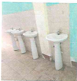
Fotos 9: Cambio de pedestales para adaptarlo a la altura de los niños y hacer un uso mas eficiente del agua.
