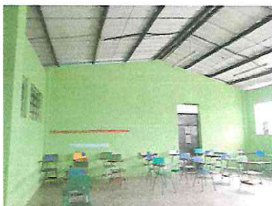
Foto 5: Se colocará cielo falso en 4 salones para disminuir el calor del verano y el ruido que producen las lluvias en invierno, para mayor efectividad de las clases.
