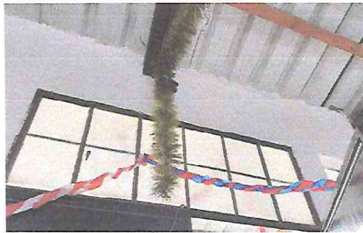
Foto 2: REPARACIÓN DE VIDRIOS DE VENTANAS
