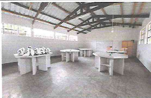
Foto 1: CONSTRUCCIÓN DE 5 MESAS DE CONCRETO CON AZULEJO PARA LABORATORIO DE BIOLOGÍA.
