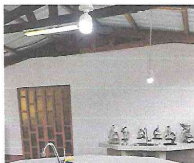
Foto 4: CONSTRUCCIÓN DE ENTREPAÑO CON PUERTA DE ACCESO.
