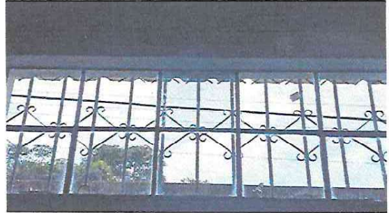
Foto 2: REPARACIÓN DE VIDRIOS DE VENTANAS PARA LABORATORIO DE BIOLOGÍA.
