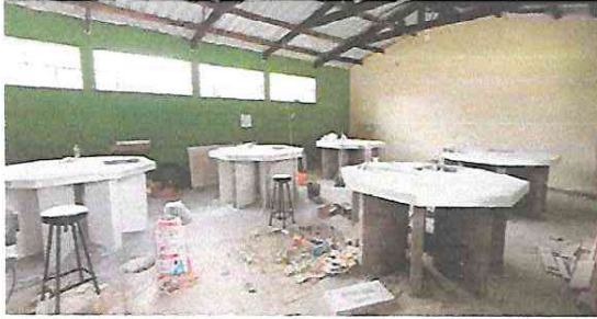
Foto 1: CONSTRUCCIÓN DE 5 MESAS DE CONCRETO CON AZULEJO PARA LABORATORIO DE BIOLOGÍA.
