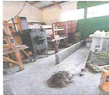
Foto 4: CONSTRUCCIÓN DE ENTREPAÑO CON PUERTA DE ACCESO.
