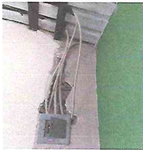
Foto 3: REPARACIÓN DE TOMA CORRIENTES, APAGADORES Y SISTEMA ELÉCTRICO EN GENERAL.
