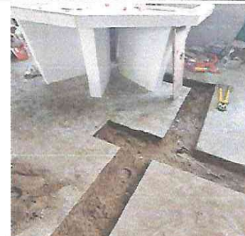
Foto 6: INSTALACIÓN QUE INCLUYE DRENAJE, AGUA POTABLE, CONEXIÓN ELÉCTRICA Y SISTEMA DE GAS PARA LABORATORIO DE BIOLOGÍA.
