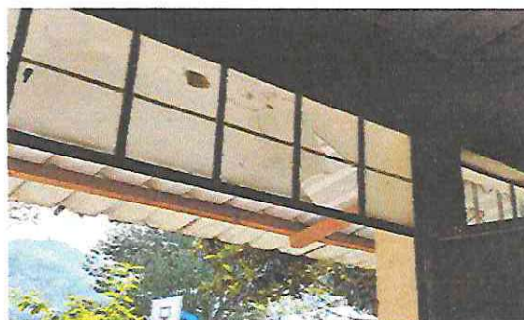
Foto 2: REPARACIÓN DE VIDRIOS DE VENTANAS PARA LABORATORIO DE BIOLOGÍA.
