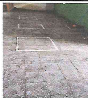
Foto 6: INSTALACIÓN QUE INCLUYE DRENAJE, AGUA POTABLE, CONEXIÓN ELÉCTRICA Y SISTEMA DE GAS PARA LABORATORIO DE BIOLOGÍA.
