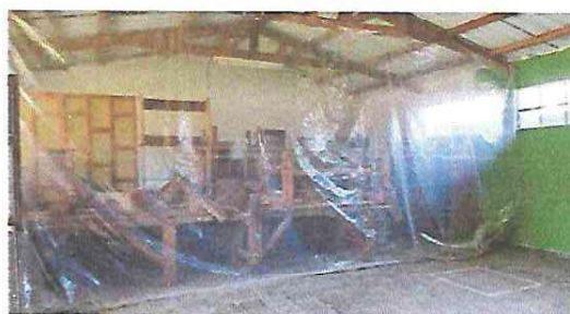
Foto 4: CONSTRUCCIÓN DE ENTREPAÑO CON PUERTA DE ACCESO.
