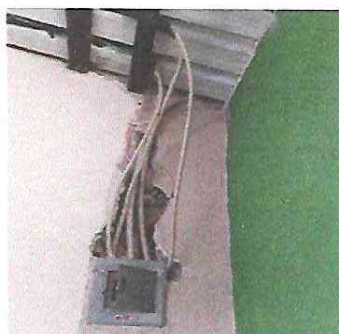
Foto 3: REPARACIÓN DE TOMA CORRIENTES, APAGADORES Y SISTEMA ELÉCTRICO EN GENERAL.
