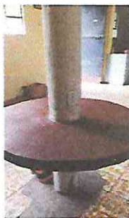
Foto 1: CONSTRUCCIÓN DE 5 MESAS DE CONCRETO CON AZULEJO PARA LABORATORIO DE BIOLOGÍA.
