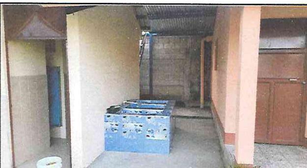
Foto 3: REPARACIÓN DE COCINA: sustitución de pila de cemento de dos lavaderos
