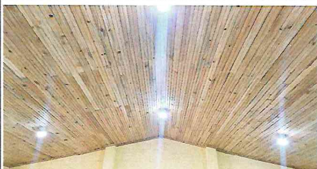
Foto 1: CUBIERTA DE LÁMINA: colocacion de machimbre en un salón de clases
