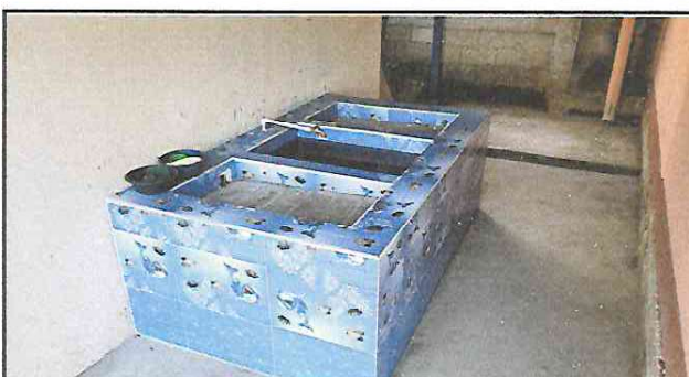
Foto 4: REPARACIÓN DE COCINA: sustitución de pila de cemento de dos lavaderos
