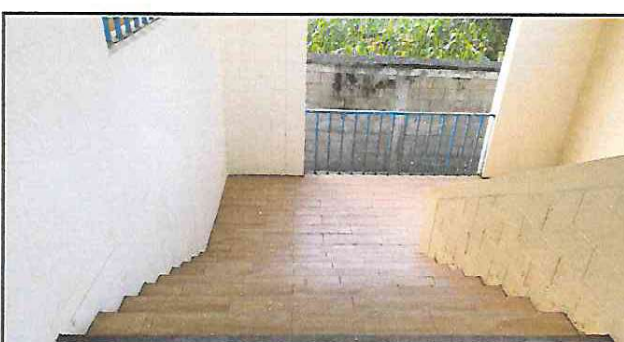
Foto 6: Colocación de piso cerámico en gradas hacia 2º nivel
