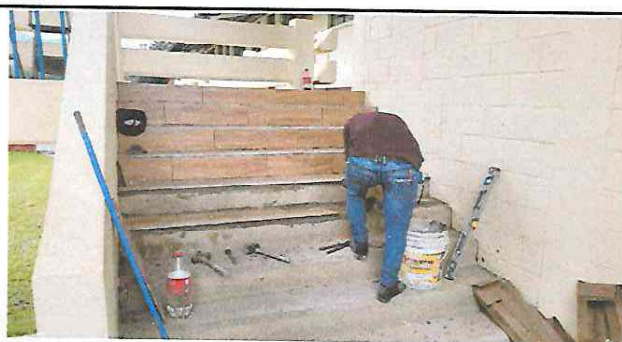
Foto 5: Colocación de piso cerámico en gradas hacia 2º nivel
