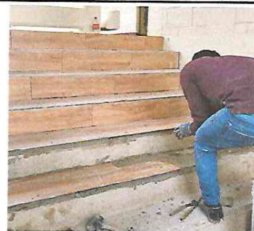
Foto 6: Colocación de piso cerámico en gradas hacia 2º nivel
