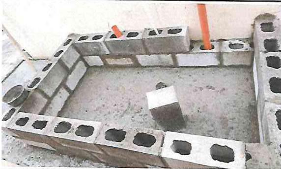
Foto 3: REPARACIÓN DE COCINA: sustitución de pila de cemento de dos lavaderos.
