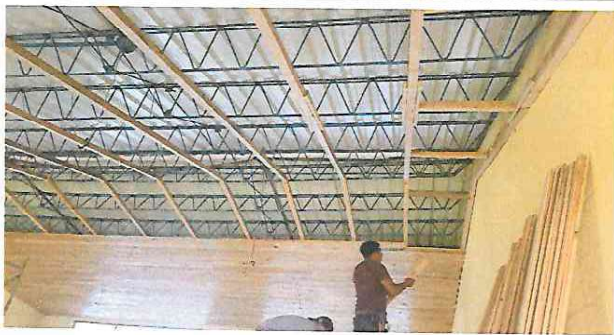
Foto 1: CUBIERTA DE LÁMINA: colocacion de machimbre en un salón de clases
