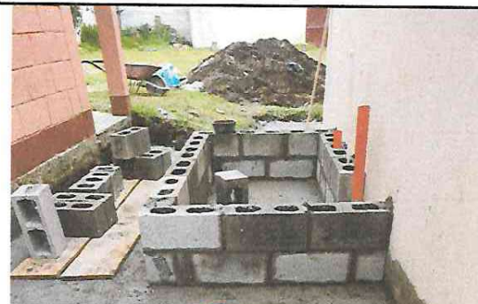
Foto 4: REPARACIÓN DE COCINA: sustitución de pila de cemento de dos lavaderos.
