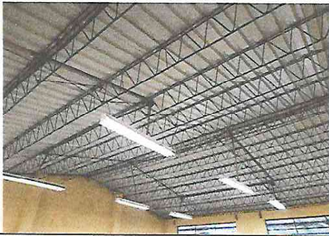
Foto 1: CUBIERTA DE LÁMINA: colocación de machimbre en un salón de clases
