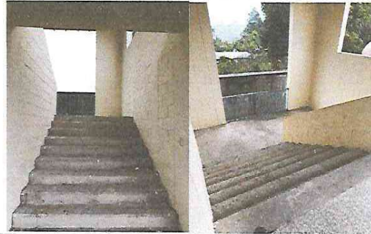
Foto 2: PISO: colocación de piso cerámico en gradas hacia al segundo nivel.
