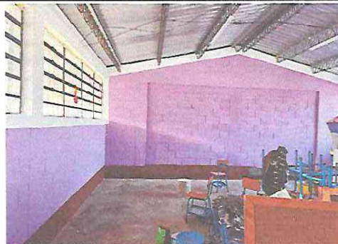
Foto 2: Pintado de paredes del interior de 4 salones de clase, la cocina y dirección, y pintado de puertas
