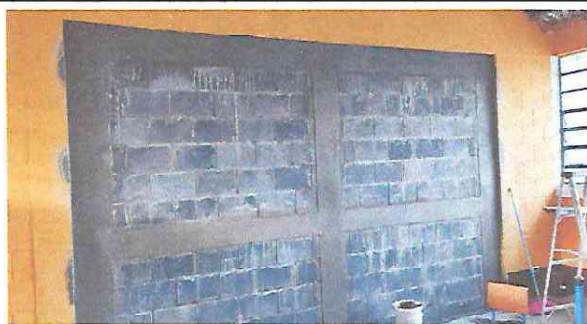
Foto 1: Cambiar dos divisones de madera por pared de block
