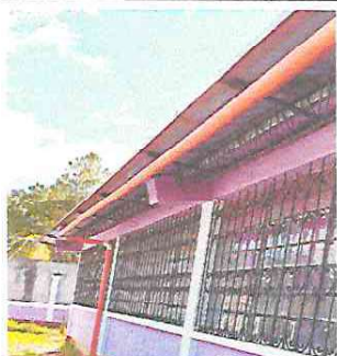
Foto 5: Mejoramiento de bajada pluvial
