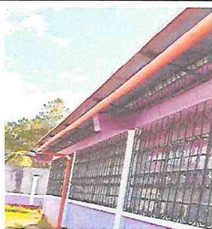
Foto 5: Mejoramiento de bajada pluvial
