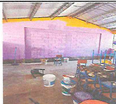
Foto 2: Pintado de paredes del interior de 4 salones de clase, la cocina y dirección, y pintado de puertas
