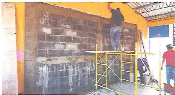
Foto 1: Cambiar dos divisiones de madera por pared de block
