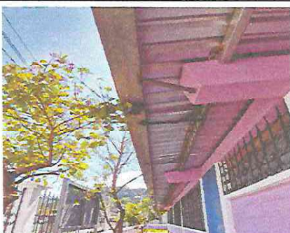
Foto 5: Mejoramiento de bajada pluvial
