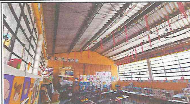
Foto 2: Pintado de paredes del interior de 4 salones de clase, la cocina y dirección, y pintado de puertas
