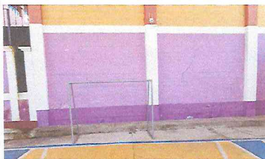
Foto 4: Losa de Patio. Realizar un pequeño escenario por el espacio
