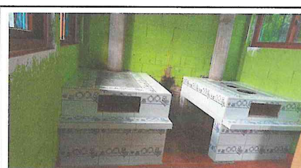
Foto 4: Estufas rurales terminadas.
