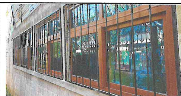
Foto 5: Colocacion de ventanas y balcones terminados.
