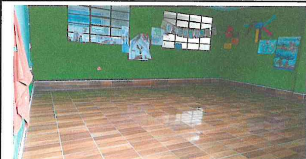
Foto1: colocacion de pisos finizados
