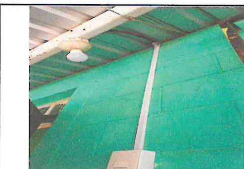
Foto 3: sistema electrico reparado.
