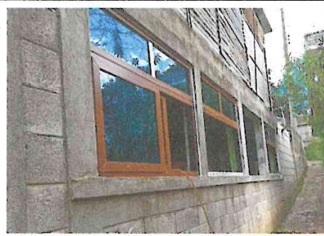
Foto 4: cambio de vidrios y ventanas.
