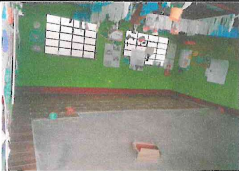
Foto1: Cambio de piso en mal estado.
