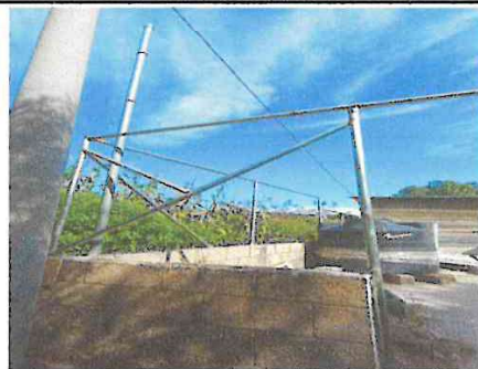
Foto 2: colocacion de malla para seguridad de agua tinaco de la escuela.
