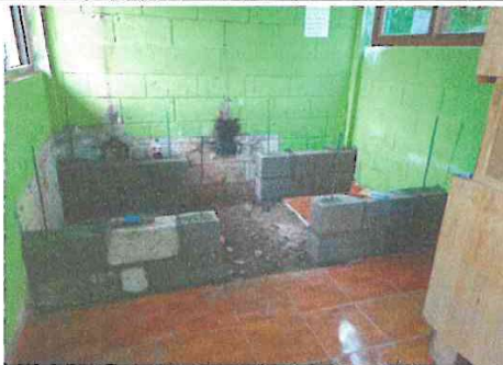
Foto 3: sustitucion de estufa en mal estado.
