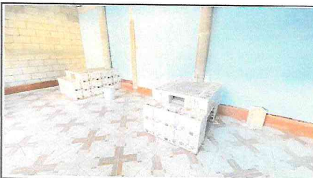
Reparación de área de cocina
