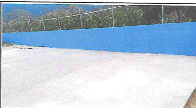
Pintura de muros interior y exterior
