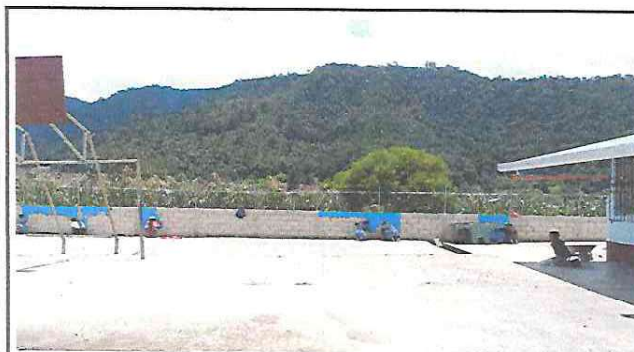
Pintura de muros interior y exterior
