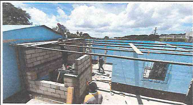
Cubierta de láminas
