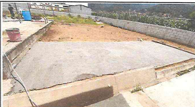
Losa de patio
