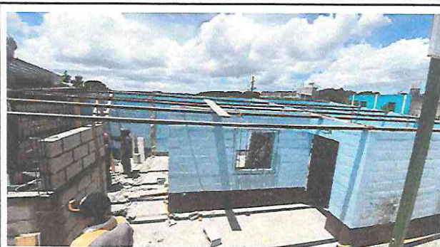
Estructura de techo
