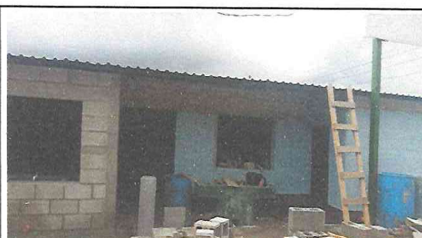
Canaletas y bajadas de agua
