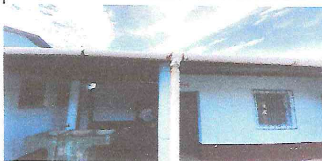
Canales y bajadas de agua pluvial
