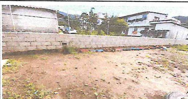
Pintura de muros interior y exterior
