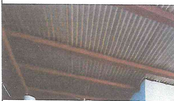
Estructura de techo
