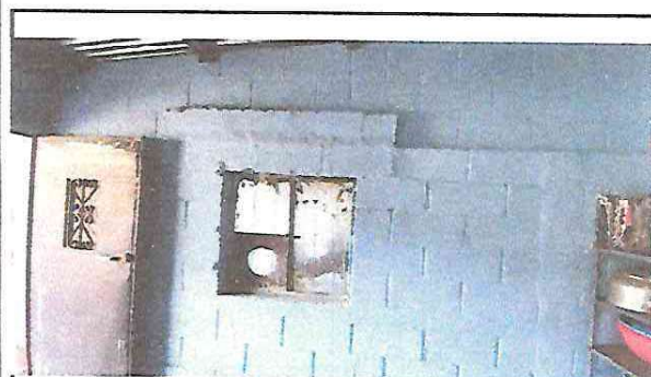
Reparación de repello y cernido de paredes
