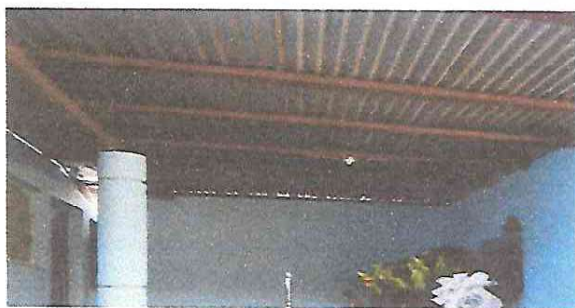
Cubierta de láminas
