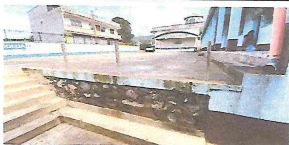
Mantenimiento de barandas
