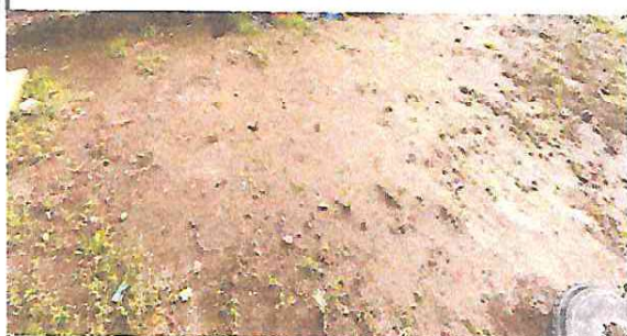
Losa de patio
